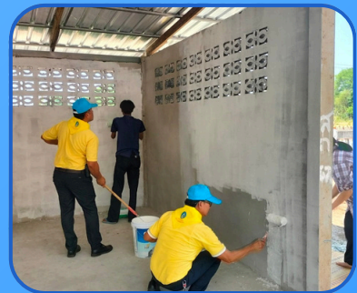
ทาสีอาคารเก็บของวัดทุ่งสว่างคงคา
